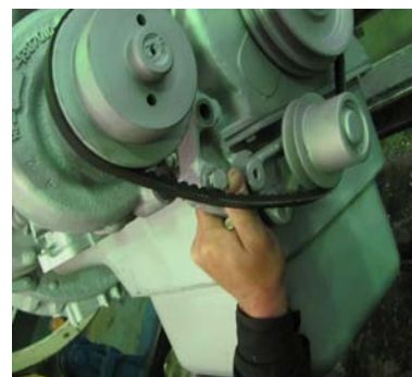
Рисунок 4.30а Установка натяжного устройства
